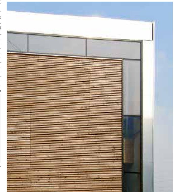
Finestre a nastro di collegamento tra rivestimento di legno della facciata est e finitura di alluminio della porzione nord
