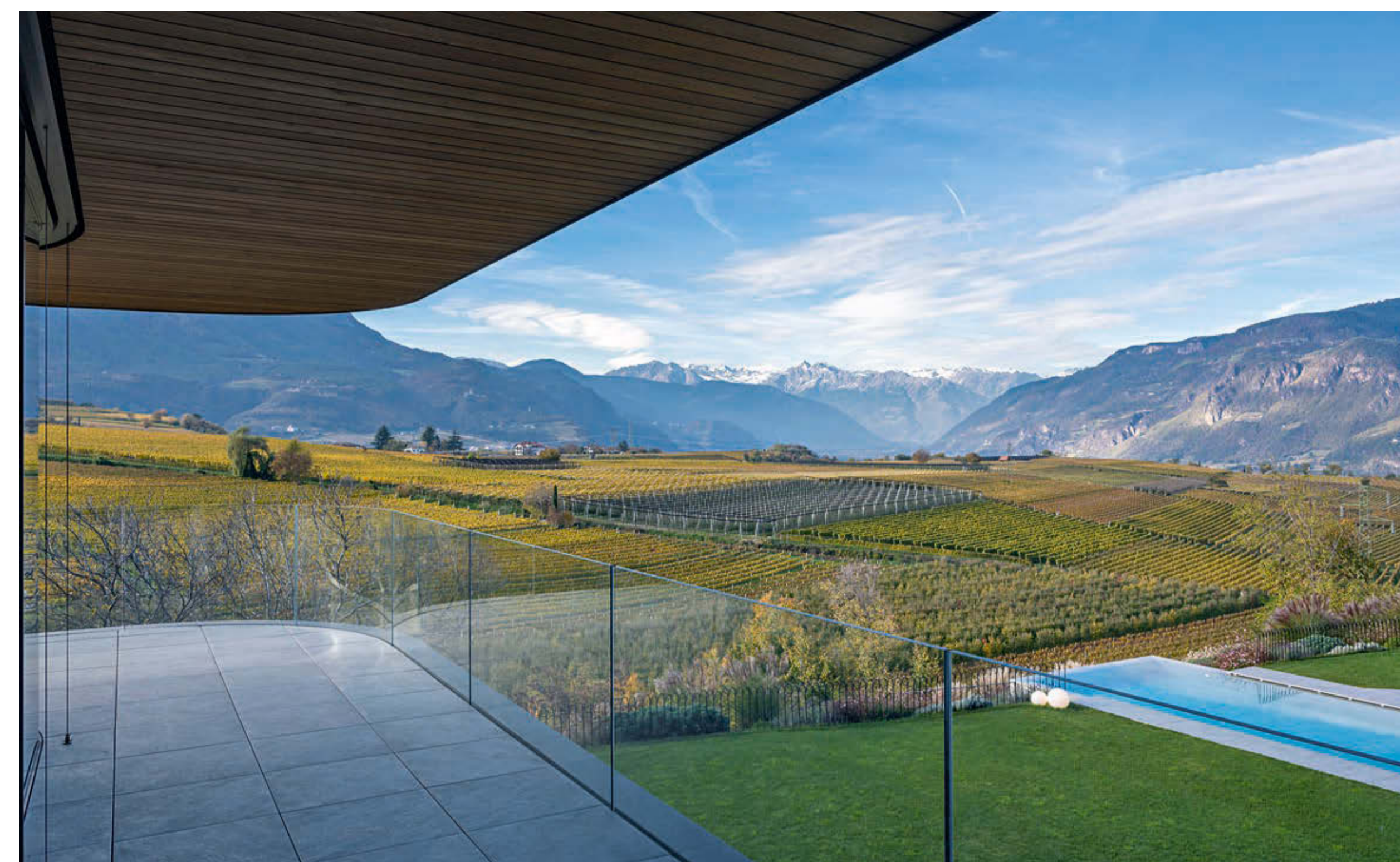
Auf allen Ebenen sind Außenräume erreichbar, von denen aus sich den Bewohnern attraktive Ausblicke auf die Umgebung bieten.
