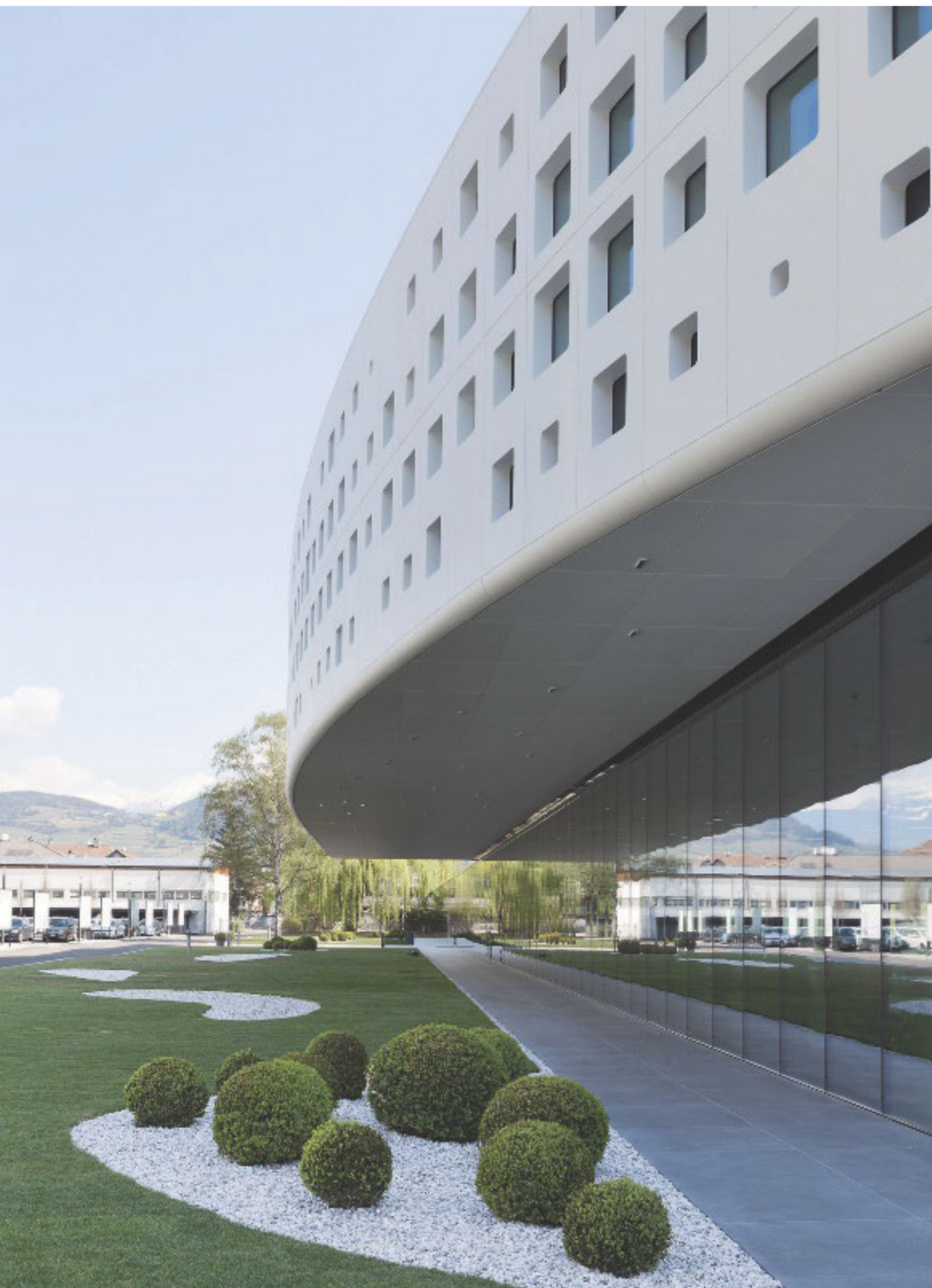
Insgesamt 842 Fensterelemente perforieren die pulverbeschichtete Metallfassade.
