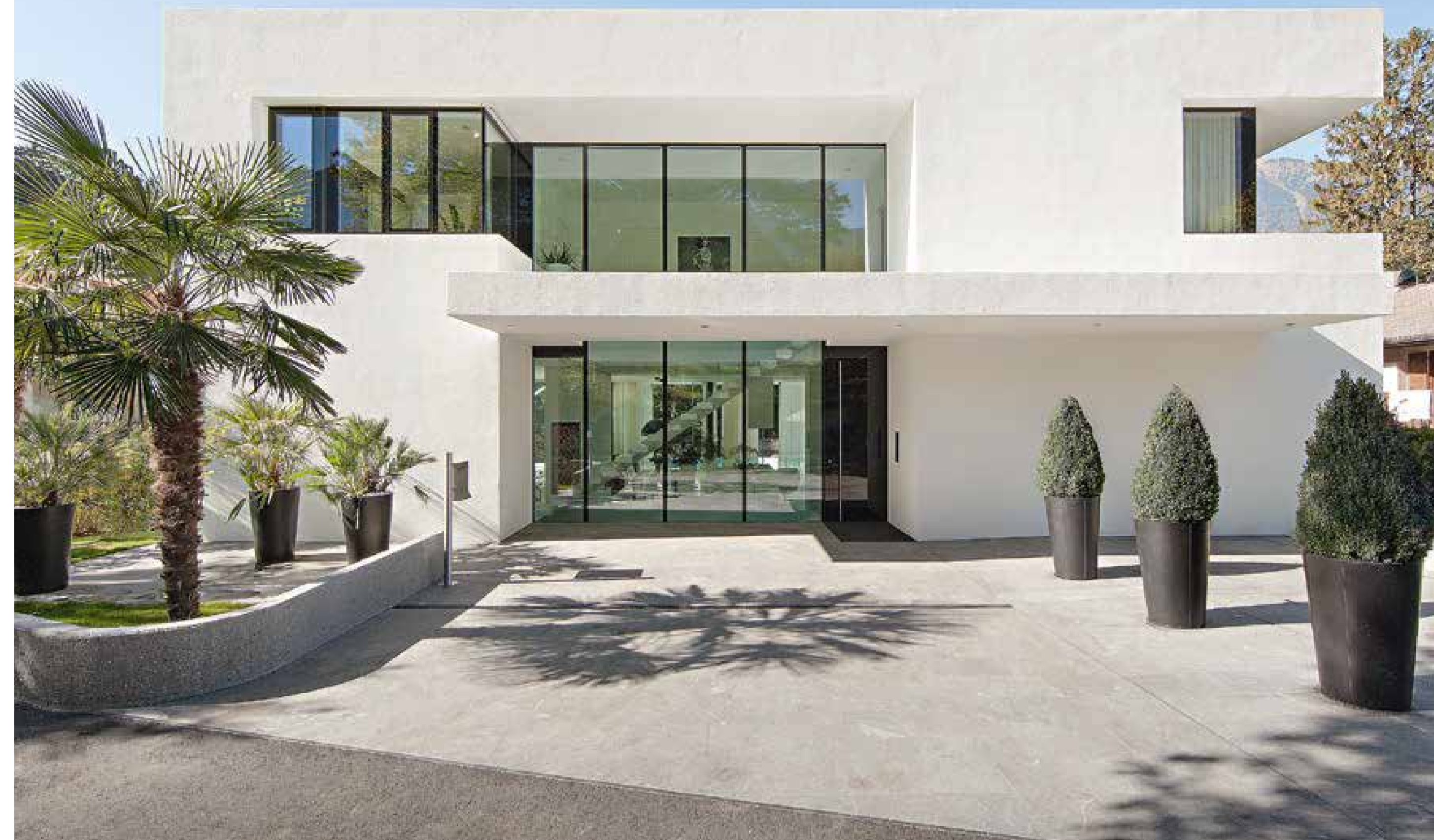
Kaum zu sehen, aber er ist da: der Autoaufzug. Die Plattform erhebt sich vor dem Eingang und bringt Fahrzeuge in die unter dem Haus liegende Garage.
