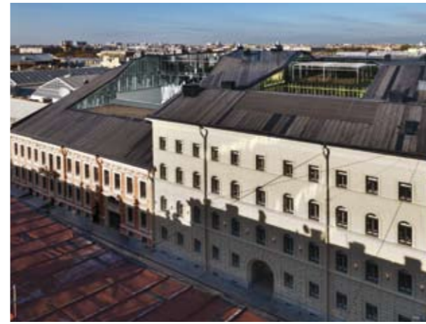
La copertura in metallo riconnette con una forma continua i due edifici, mantenendo le facciate storiche sul fronte stradale.
