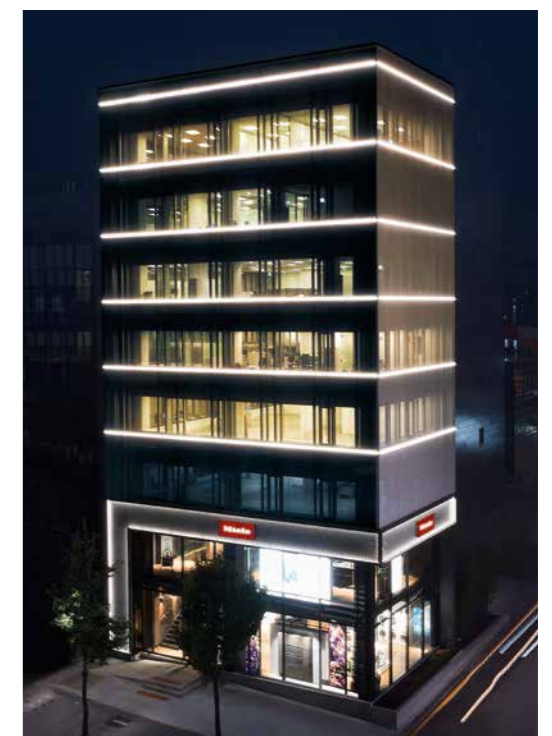
Objekt Project Ouvrage Realizzazione MIELE HAUS - MIELE KOREA HEADQUARTER KR-Seoul, 2020
