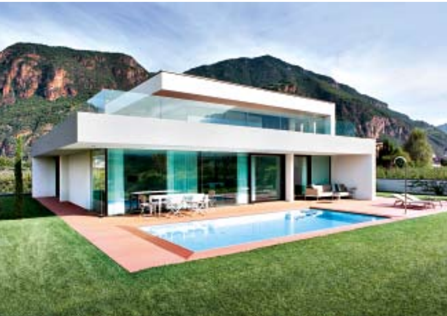
Caratteristici dell’edificio sono i tetti fortemente aggettanti; in estate proteggono l’area giorno, completamente vetrata, dall’eccessivo irraggiamento solare.
