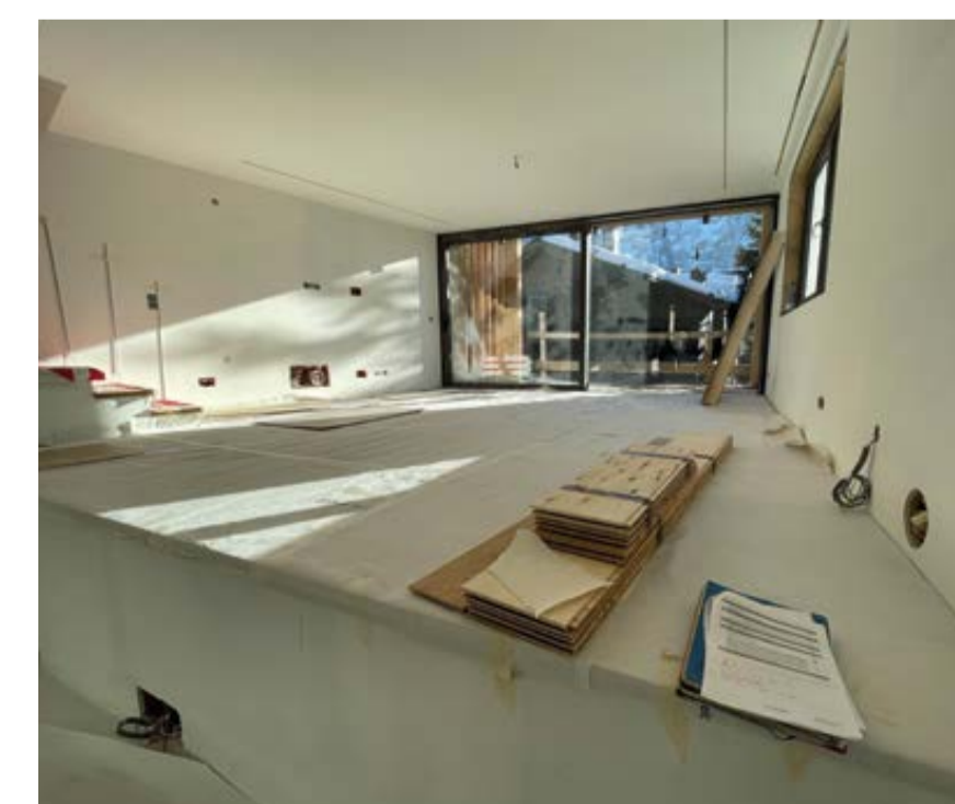
Posa della pavimentazione in parquet e ultimazione del camino nell'area living.
