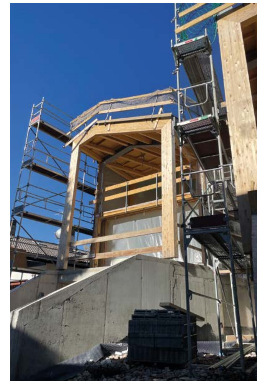
Realizzazione del piano seminterrato e della struttura in legno dei livelli superiori.
